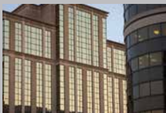
Construção Janelas e portas
